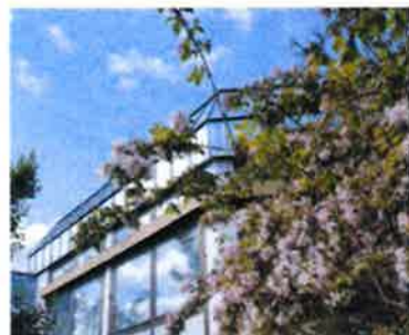
Das Gemeindehaus wäre der erste Kandidat für Photovoltaik.
