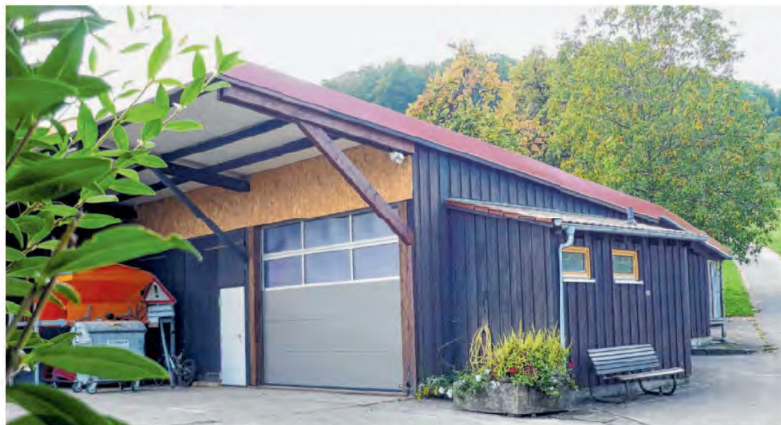
Der Altbau des Gammelshäuser Bauhofs ist ertüchtigt und wird am 3. Oktober wieder zum Schauplatz des Apfelhocks. Rechts vom Weg, der zum Obstlehrpfad und Köpfe führt, soll eine Gerätehalle dazukommen. Foto: Jürgen Schäfer
