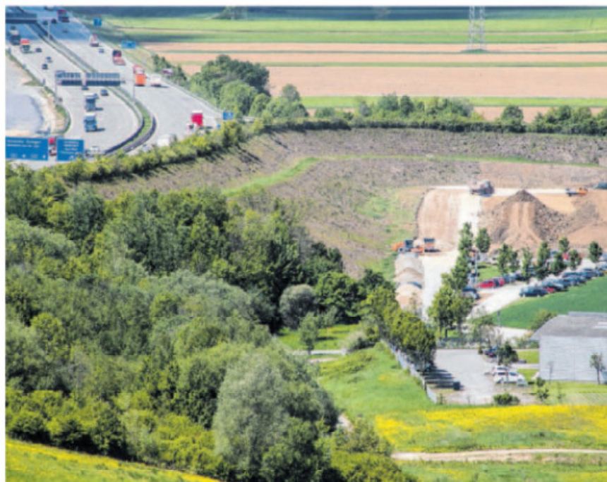
Blick von Aichelberg auf das Gelände für einen gewünschten Gewerbepark an der Autobahn. In der Bildmitte rechts der Mitfahr-Parkplatz, dahinter werden Erdmassen am Damm vor der Auffahrt nach Stuttgart aufgefüllt. Die größere Fläche läge dahinter Richtung Holzmaden.
