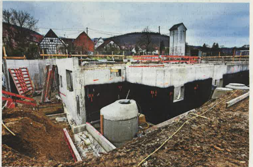
Ende dieses Jahres soll der Neubau stehen.
